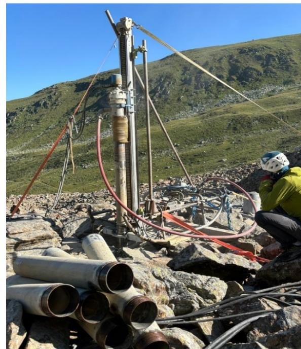
*Renouvellement d'un forage pour les mesures à long terme du pergélisol sur le glacier rocheux de Muragl en Haute-Engadine (Photo: J. Noetzli)*
