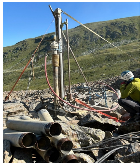
Ersatzbohrung auf dem Blockgletscher Muragl im Oberengadin für langfristige Temperaturmessungen im Permafrost (Foto: J. Noetzi)
